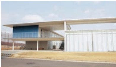
大学淑楓館竣工(平成12年)
