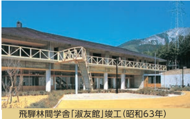
飛驒林間学舎「淑友館」竣工(昭和63年)
