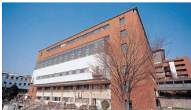
創立85周年記念事業として竣工した中央棟(平成3年)
