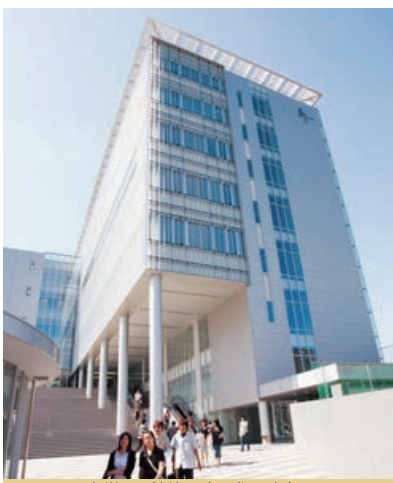
大学1号館竣工(平成16年)
