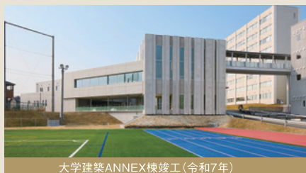
大学建築ANNEX棟竣工(令和7年)
