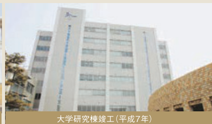
大学研究棟竣工(平成7年)
