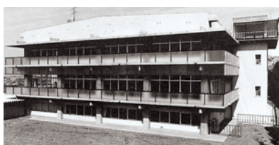
短期大学の清明館（昭和43年）。1階に学長室、会議室、和室等、2階に学生食堂、3階に図書館と大講義室等があった
