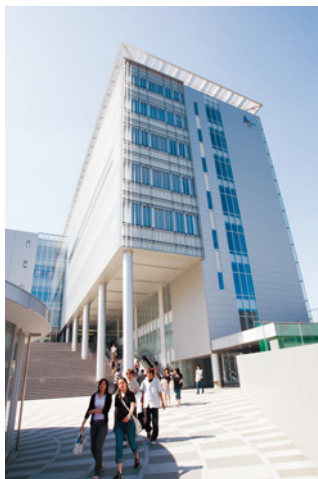
大学1号館竣工(平成16年)
