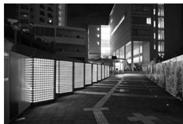
星が丘キャンパス 正門前アプローチの 太陽光発電パネル（LEDメディアボード付）、ソーラーLED照明
