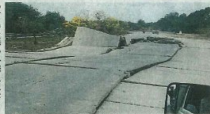
地震で舗装が隆起した道路＝4月11日、ミャンマー中部マンダレー管区で（ナインさん提供）
